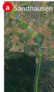
a Sandhausen Kreuzungsbauwerk, östliche Bündelung A5 mit Umfahrung Raststätte Hardtwald
