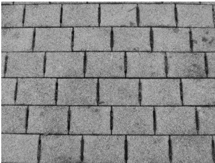
Abbildung 8: Pflasterbelag in ungebundener Pflasterbauweise
