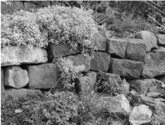
Abbildung 13: Trockenmauer
