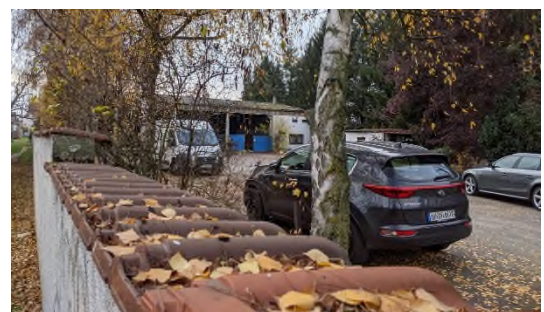
Bild 5: Gewerbehalle mit Einfriedung
