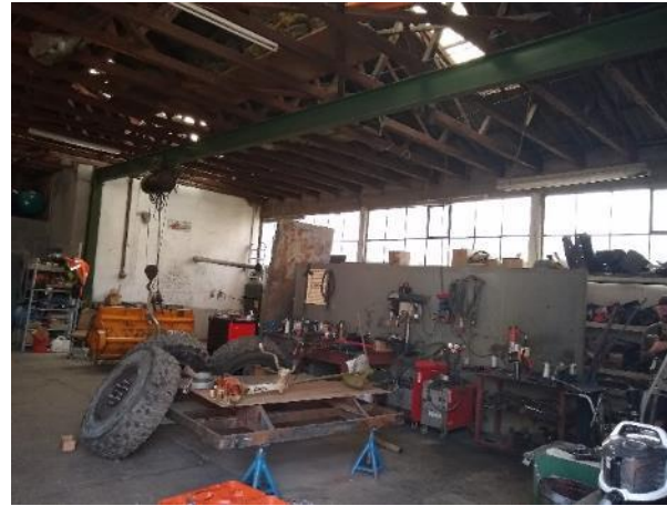
Abbildung 7: Abrissgebäude H mit Werkstatt
