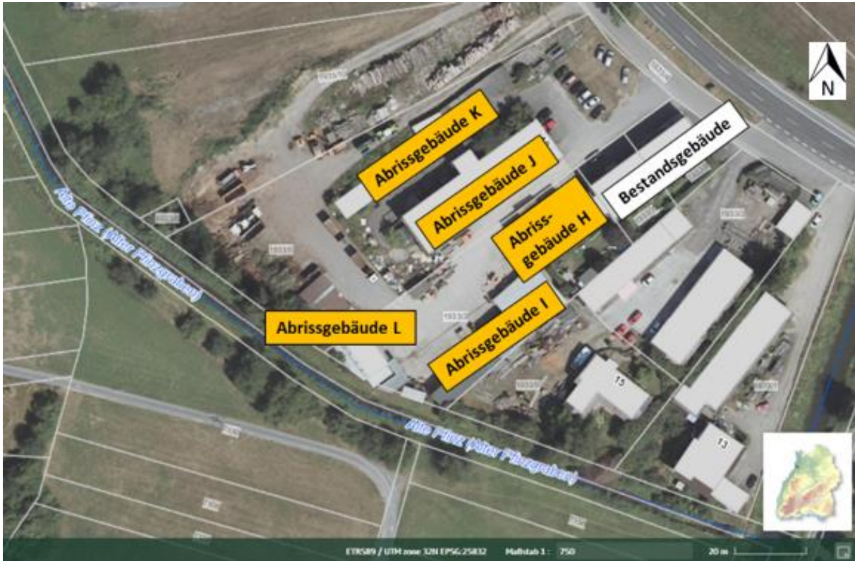
Abbildung 3: Abrissgebäude H- L innerhalb des Plangebietes
