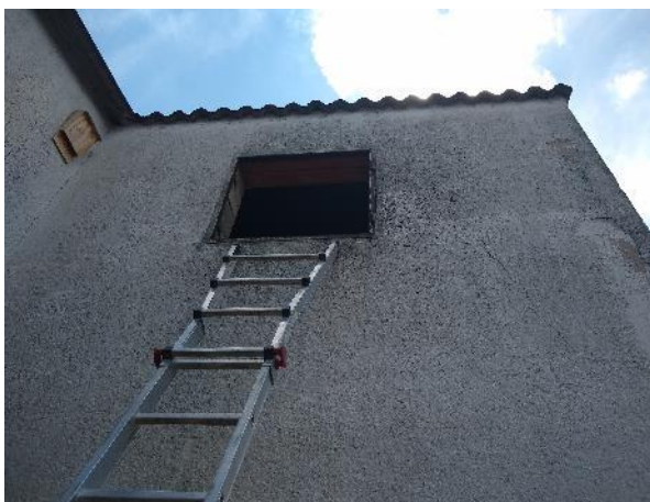
Abbildung 37: Abrissgebäude H (Anbau an der Werkstatt)
