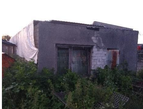
Abbildung 20: Abrissgebäude K (westliche Garage)
