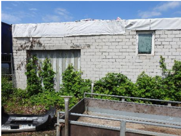
Abbildung 21: Abrissgebäude K (westliche Garage)
