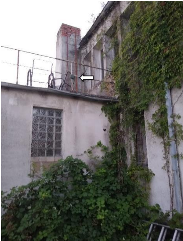
Abbildung 35: Song Meter am Abrissgebäude J
