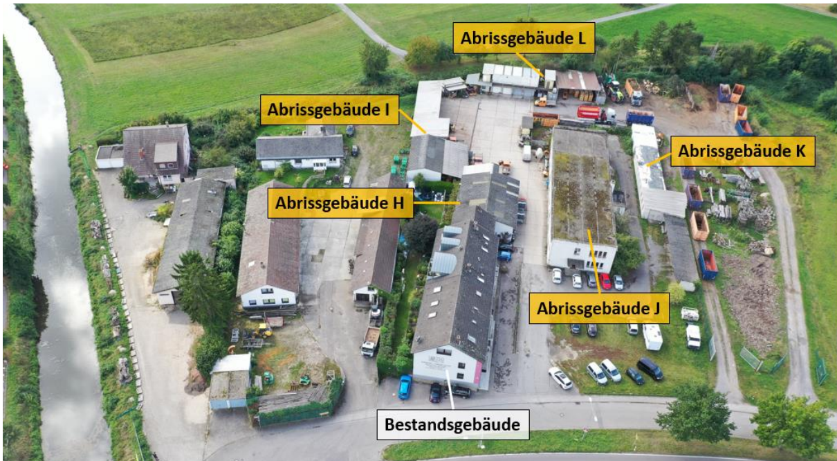
Abbildung 4: Luftaufnahme der Abrissgebäude H- L innerhalb des Plangebietes
