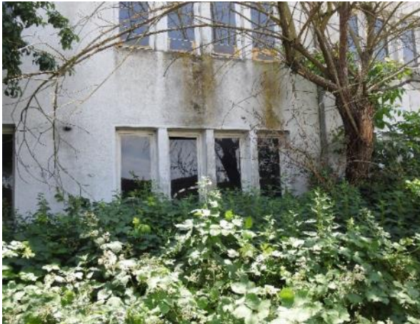
Abbildung 25: Ruderalfläche und Weide nördlich des Abrissgebäudes J
