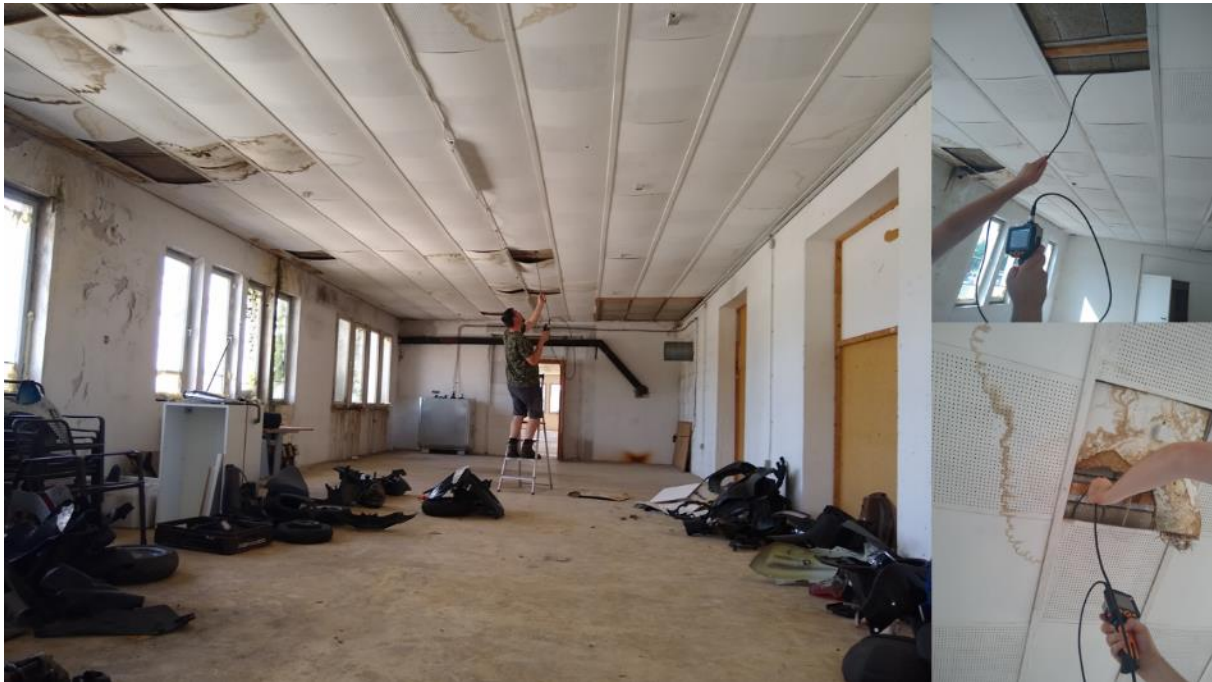
Abbildung 40: Gebäude J mit hohem Quartierpotenzial im Bereich der Decken
