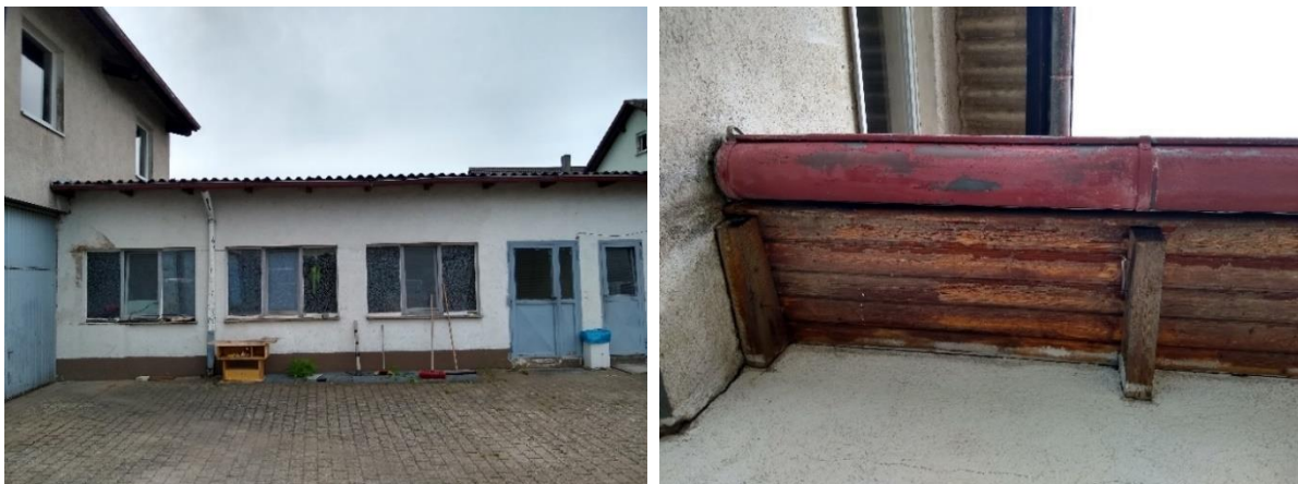
Abbildung 6: Abrissgebäude C: Aufgegebene Werkstatt
