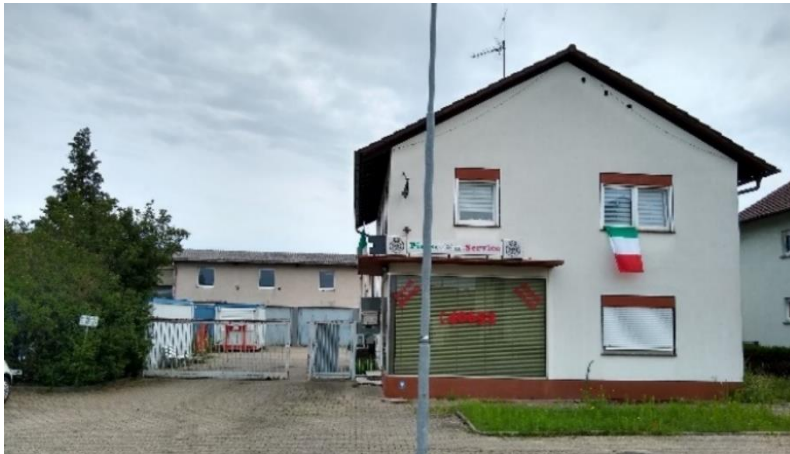
Abbildung 7: Abrissgebäude D: Wohnhaus und Pizzeria
