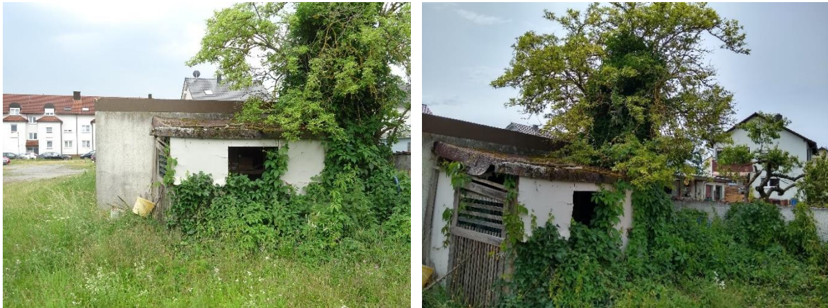
Abbildung 5: Abrissgebäude A: Schuppen
