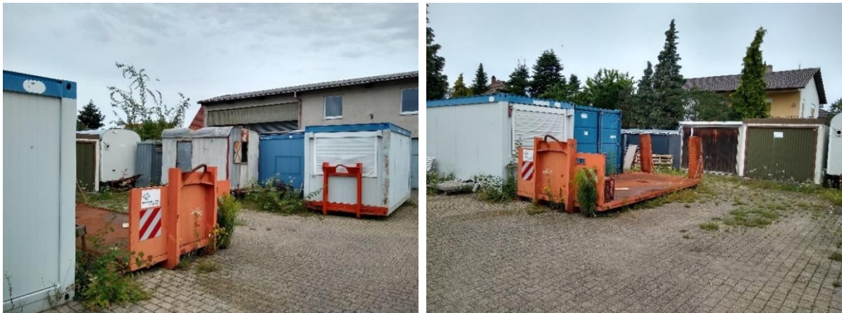
Abbildung 8: Abrissgebäude E: Container und Garagen
