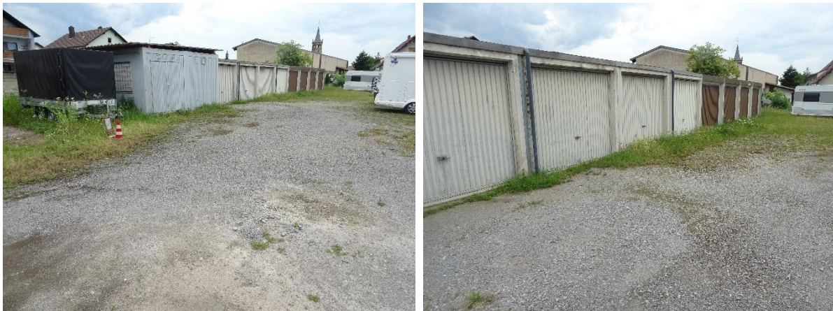
Abbildung 4: Abrissgebäude A: Container und Garagenkomplex
