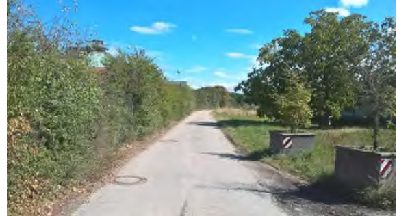
Bild 13: Eingrünung an der Kläranlage
